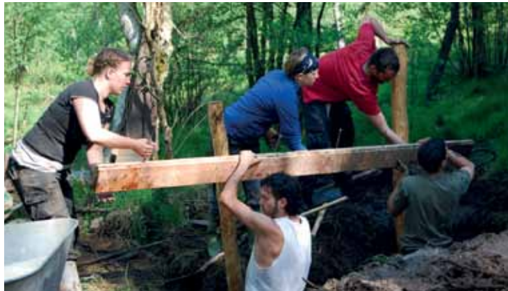
Bauen der Spuntwände
