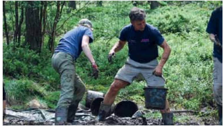
Entwässern der Gräben
