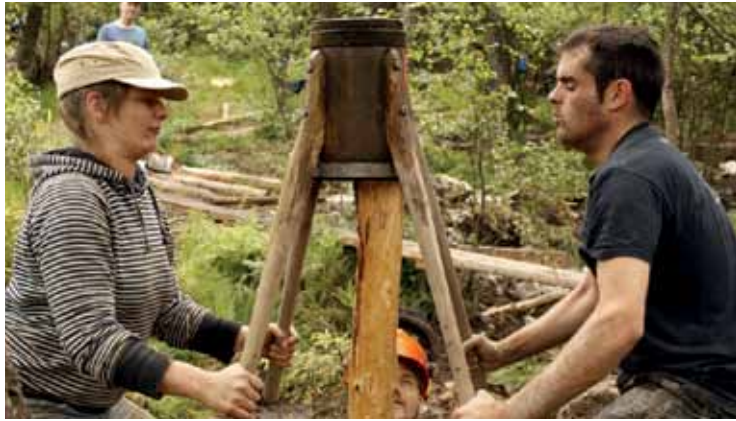
Einschlagen von Pfählen
